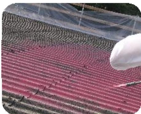
Esempio di incapsulamento. In evidenza un tecnico durante la stesura dei prodotti ricoprenti
