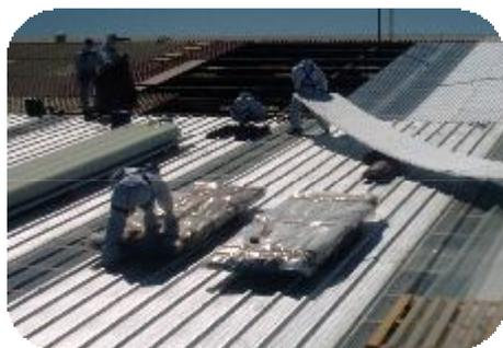
Tecnici impegnati nella rimozione e impacchettamento di sicurezza di alcuni pannelli di amianto
